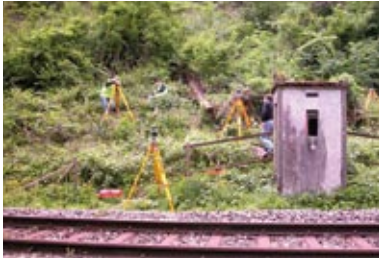
Kontrolle von Kunstbauten
