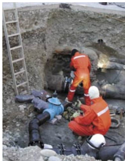
Changement d'une canalisation de gaz sous pression.
